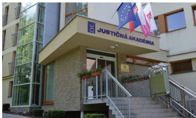
Budova Detašovaného pracoviska Justičnej akadémie Slovenskej republiky v Omšeni /Premises of the training facilities in Omšenie
