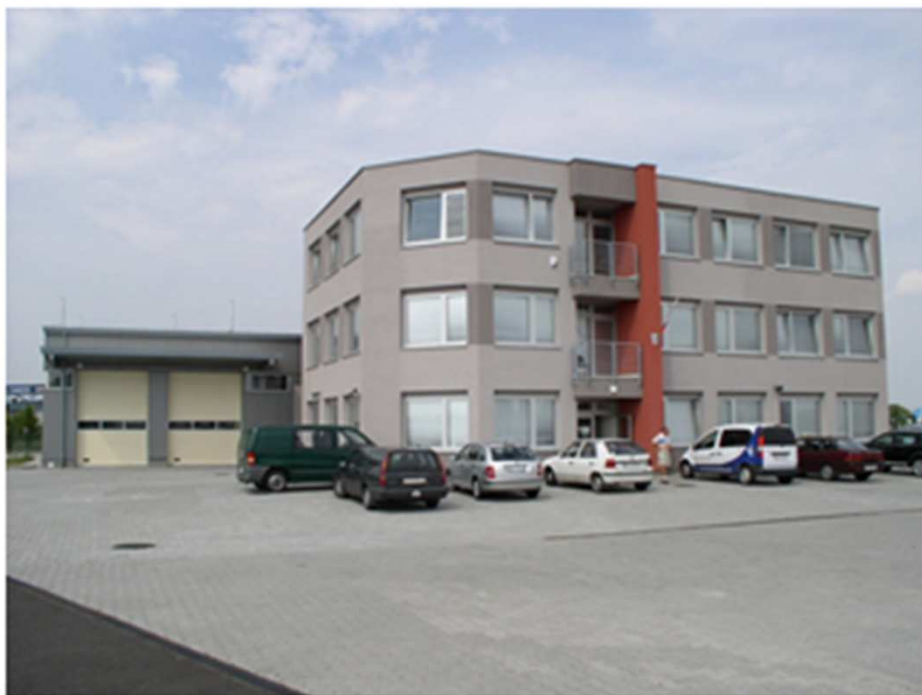
budova PCÚ Bratislava letisko
